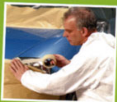
Nicht zu bearbeitende Flächen werden abgeklebt.
