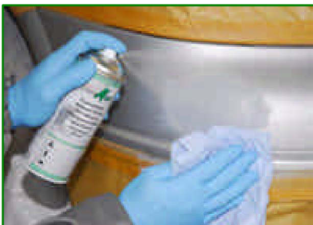
Schleifstaub entfernen, Silikon entfernen und abkleben.
