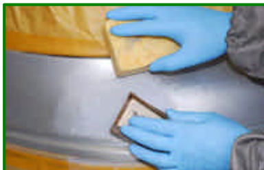
Füller mit P800 nass schleifen
