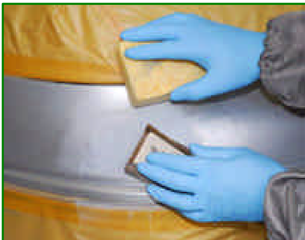
Füller mit P800 nass schleifen
