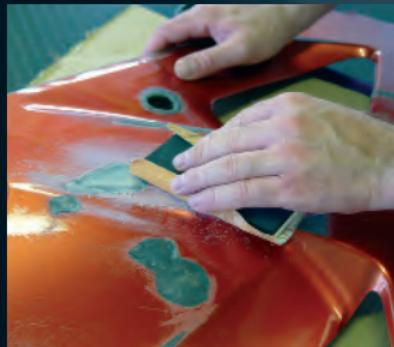
1. Die zu lackierenden Anbauteile evtl. ausbauen, gründlich reinigen, lose Teile abschleifen und für eine perfekte Haftungsgrundlage anschleifen bzw. anrauen.
