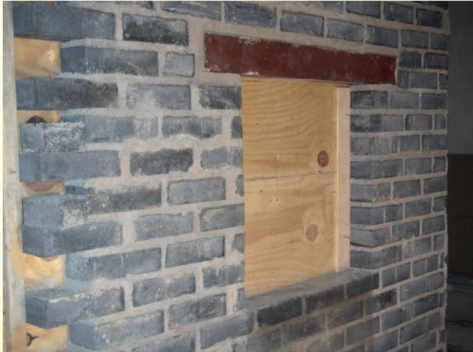
Röbalith-Steine mit den dazugehörigen Fugenmassen dienen zur Errichtung strahlenschützender Wände.
