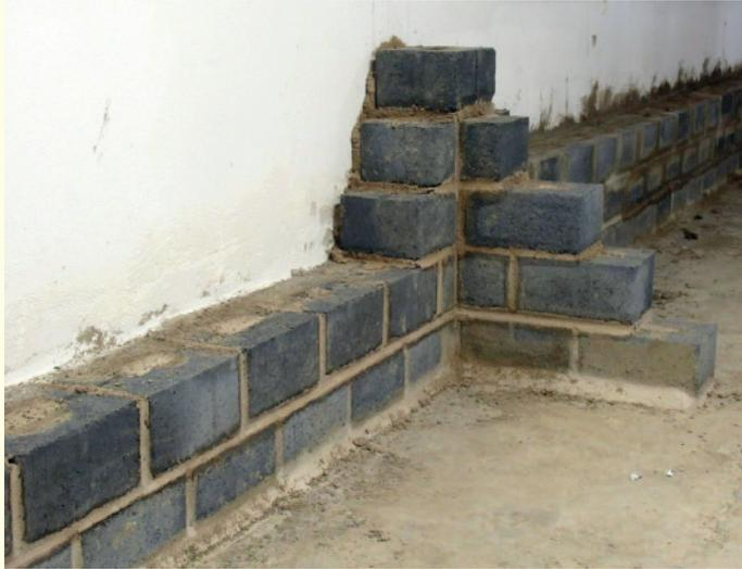
Seilo® Röbalith-Steine mit den dazugehörigen Fugenmassen dienen zur Errichtung strahlenschützender Wände.
